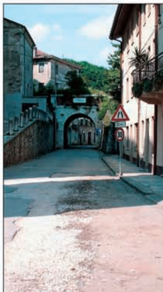
c) Rio Albo a Montecchia di Crosara (VR). Il torrente scorre sopra il ponte.
