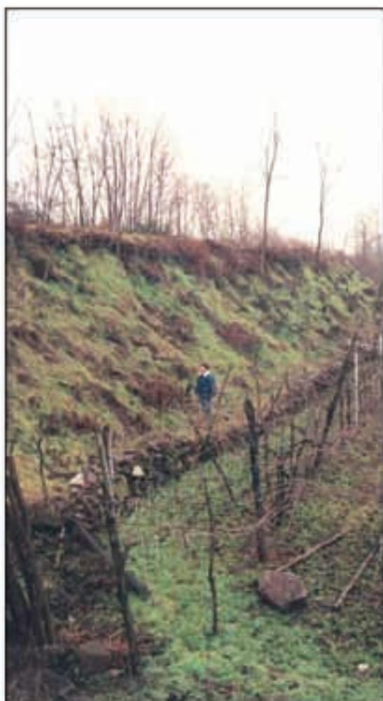
b) Torrente Rio a Gambellara (VI). Il letto del torrente è più alto del piano campagna.
