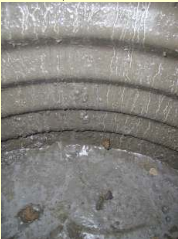
fondello pozzo drenante
