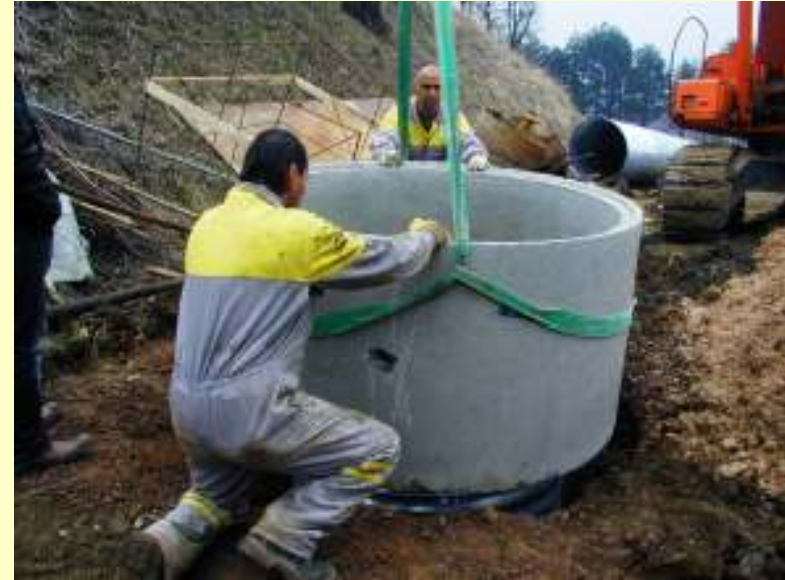
Chiusura testa pozzo
