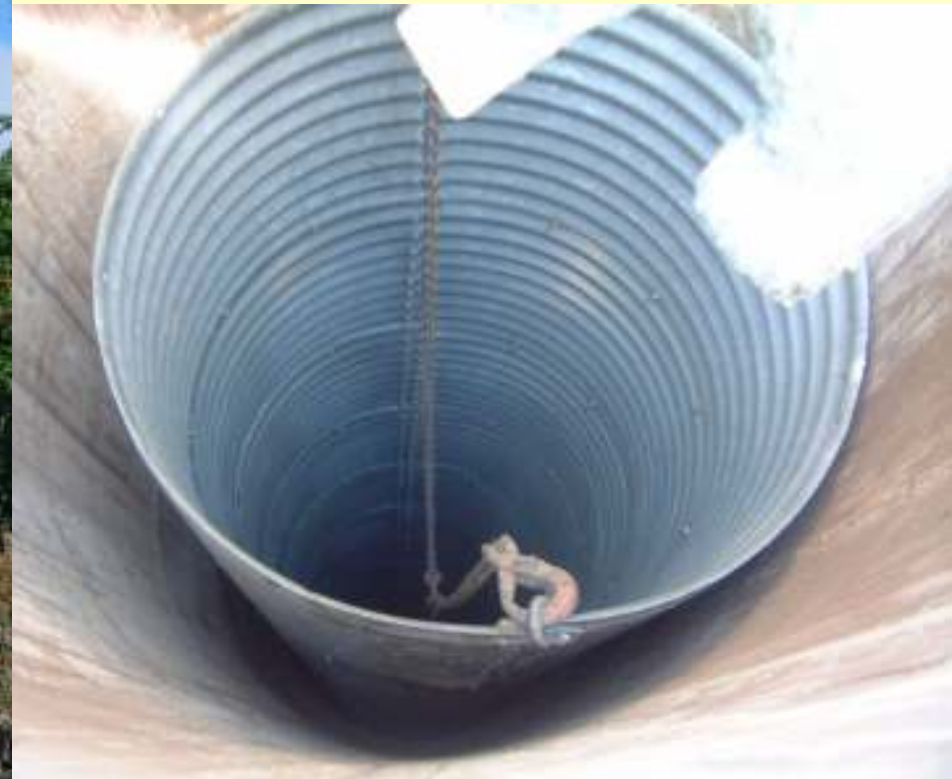
La posa del lamierino ondulato in acciaio
