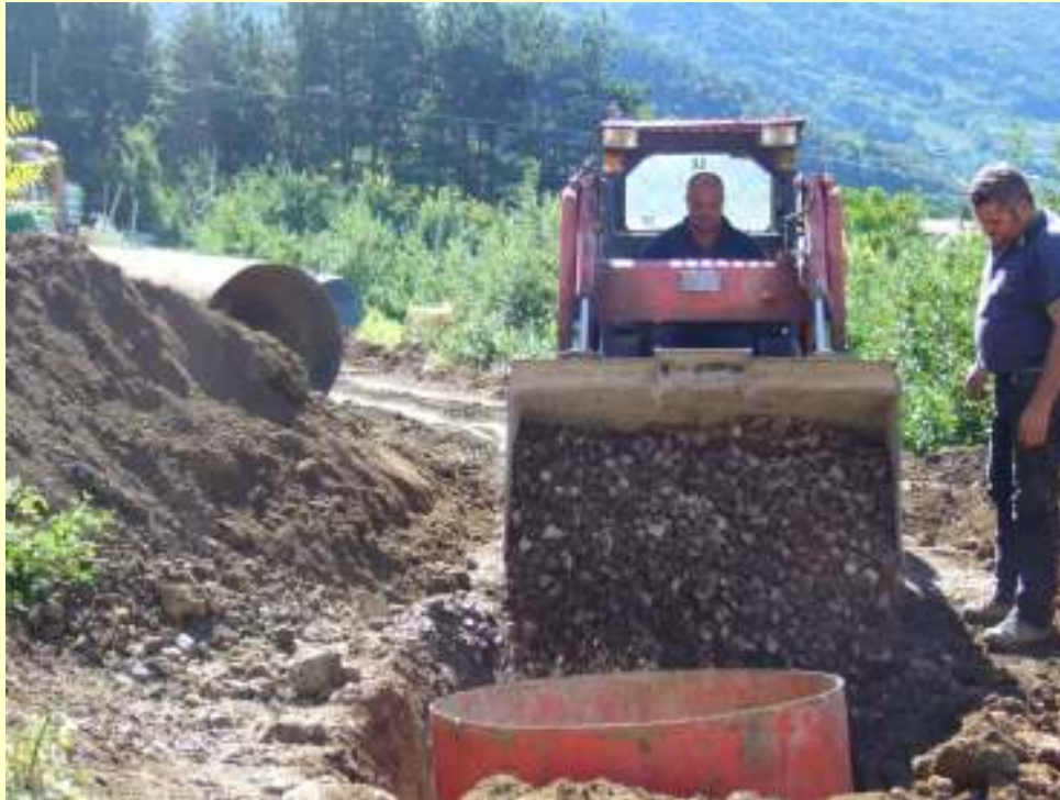
La posa del drenaggio
