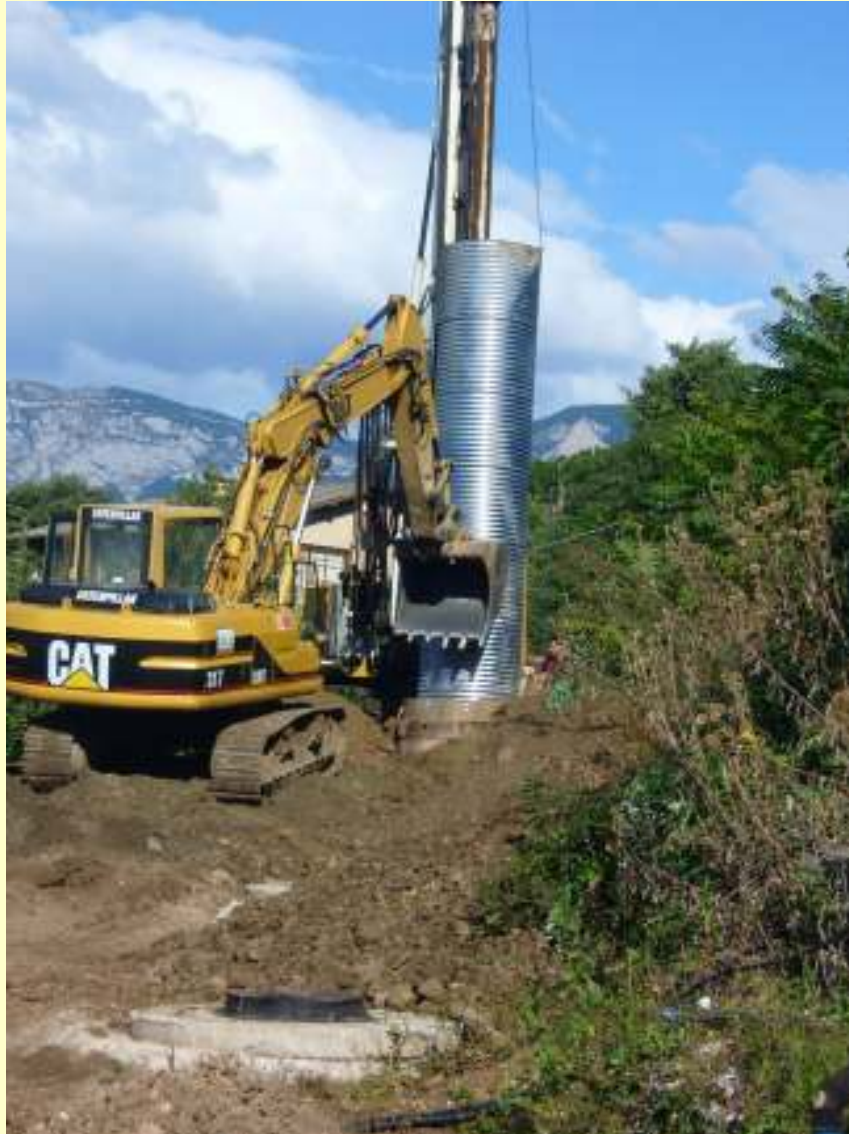
La posa del lamierino ondulato in acciaio
