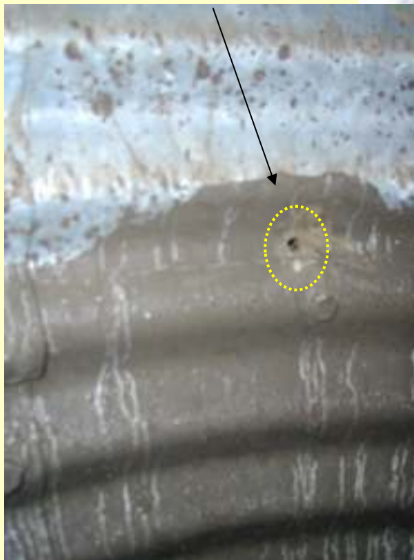
Particolare foro di testa per controllo refluito iniezione
