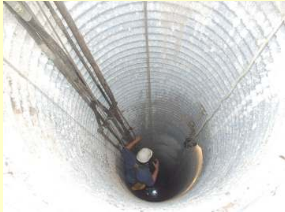
La realizzazione della condotta di fondo
