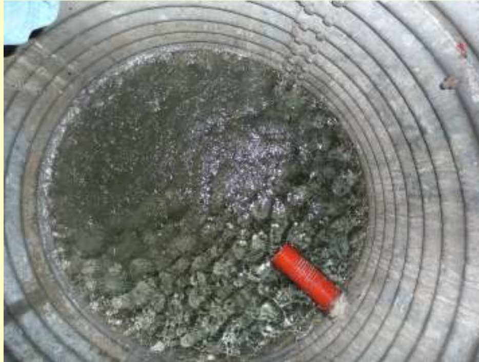
La realizzazione della condotta di fondo
