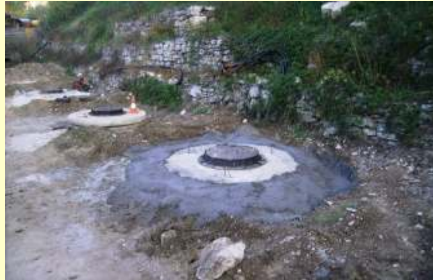
Chiusura testa pozzo
