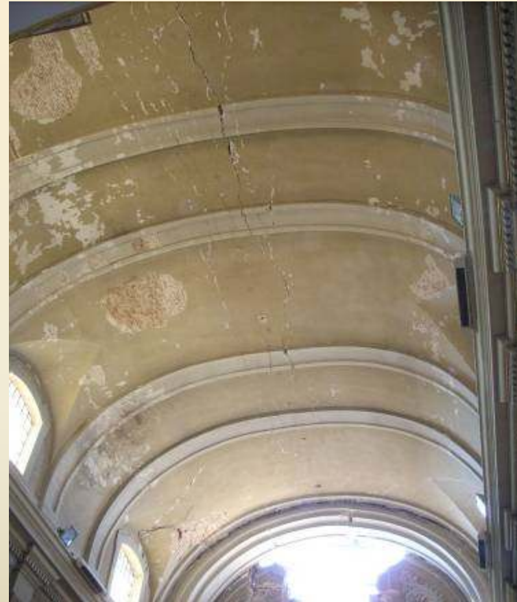
Struttura orizzontale a volta realizzata con mattoni in costa
