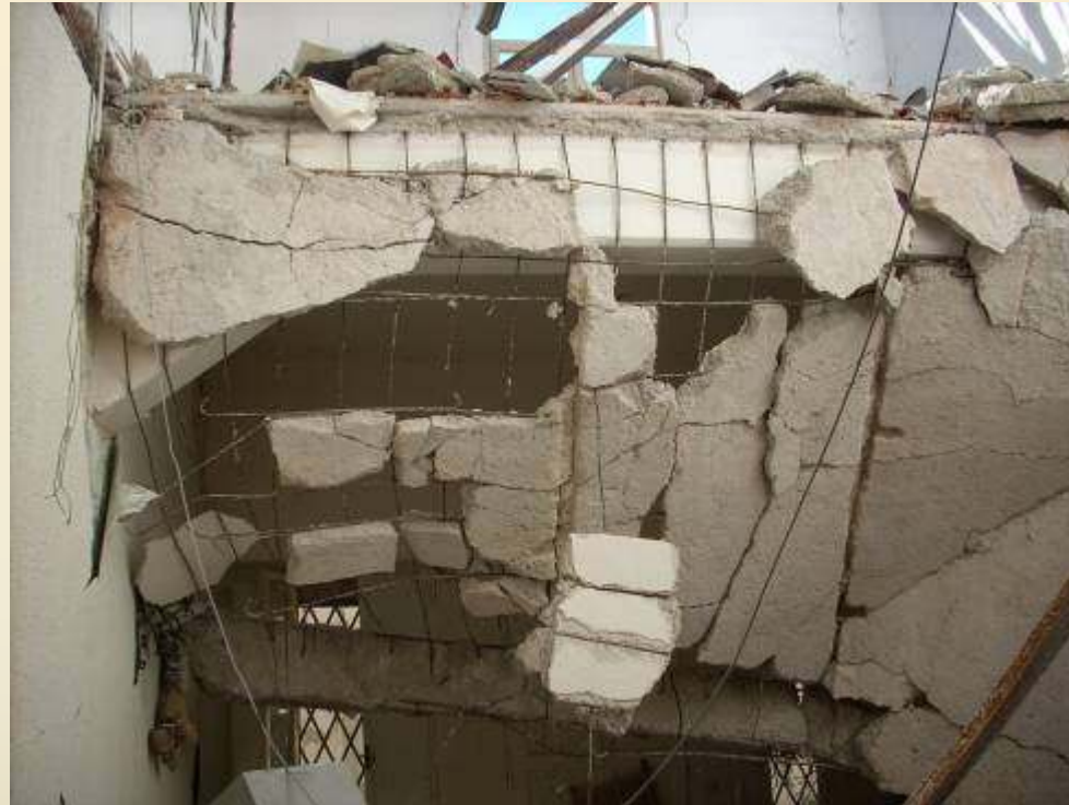
Crollo di una piastra in c.a. nella Chiesa
