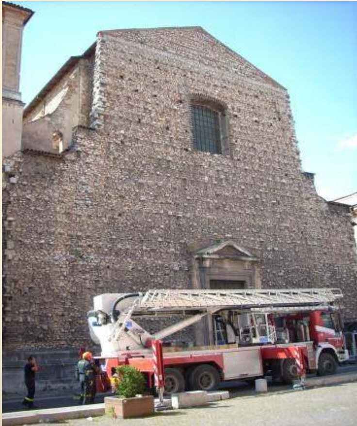
Chiesa di S. Margherita detta dei Gesuiti - Struttura portante verticale in muratura
