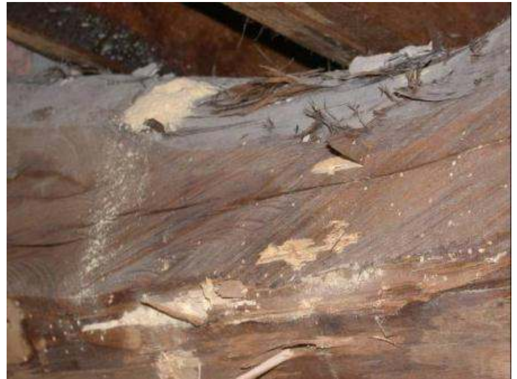
Attacco attivo (Anobidi, Cerambicidi) su trave di castagno, Duomo di Siena
