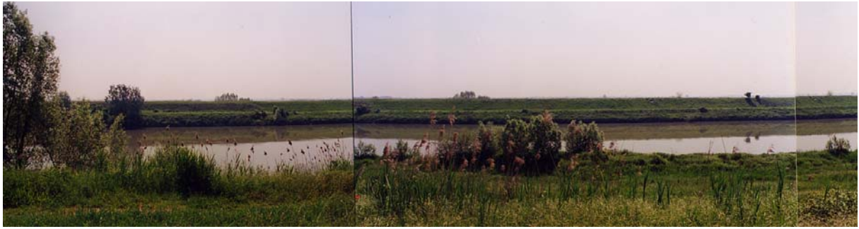
Km 338.5 – Veduta dell'argine destro del fiume.
