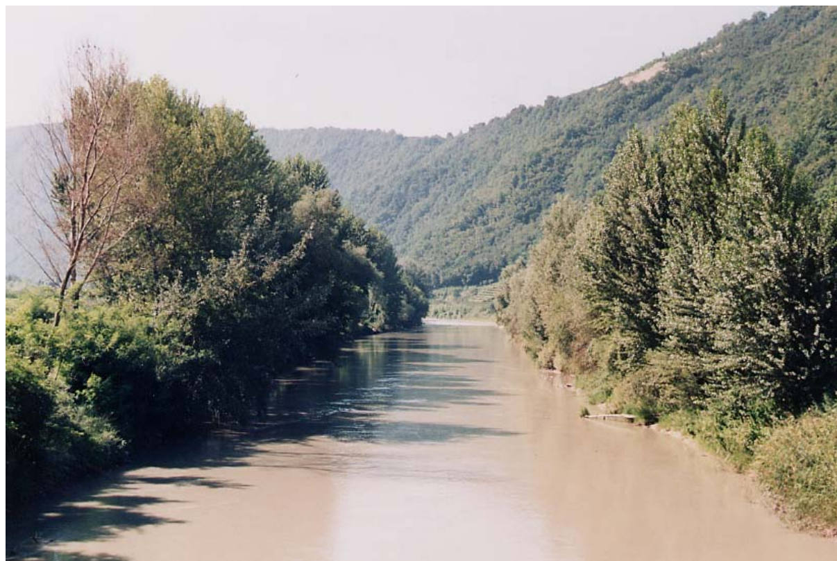
Ponte dei Frati di Novacella. Km 99.8 – Vista verso valle.
