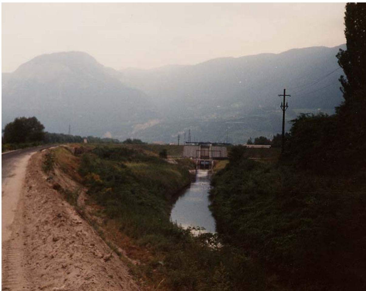
Fossa di Carezzo (o di Salorno). Km 130.5.
