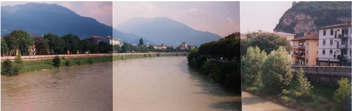
Ponte S. Giorgio. Km 152.2 – Panoramica verso sud.
