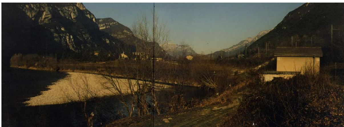
Km 208.6 – Panoramica verso nord.
