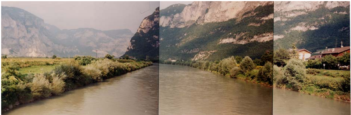
Ponte Masetto. Km 134.7 – Vista verso nord.
