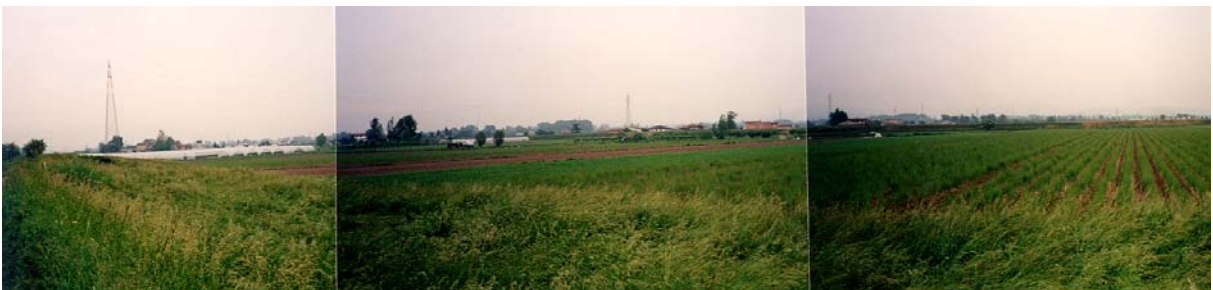
Km 273.6 – Panoramica dall'argine sinistro verso l'interno. Sul fondo si intravede l'argine del canale S.A.V.A.
