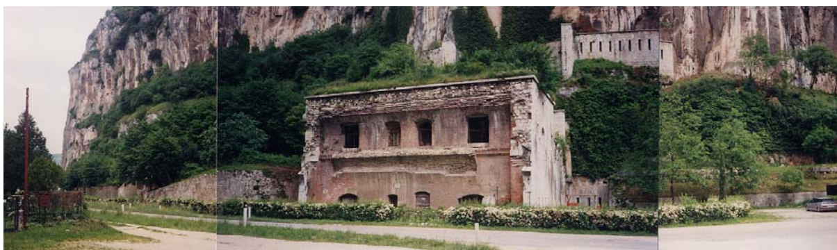
Diga di Ceraino. Km 225.4.
