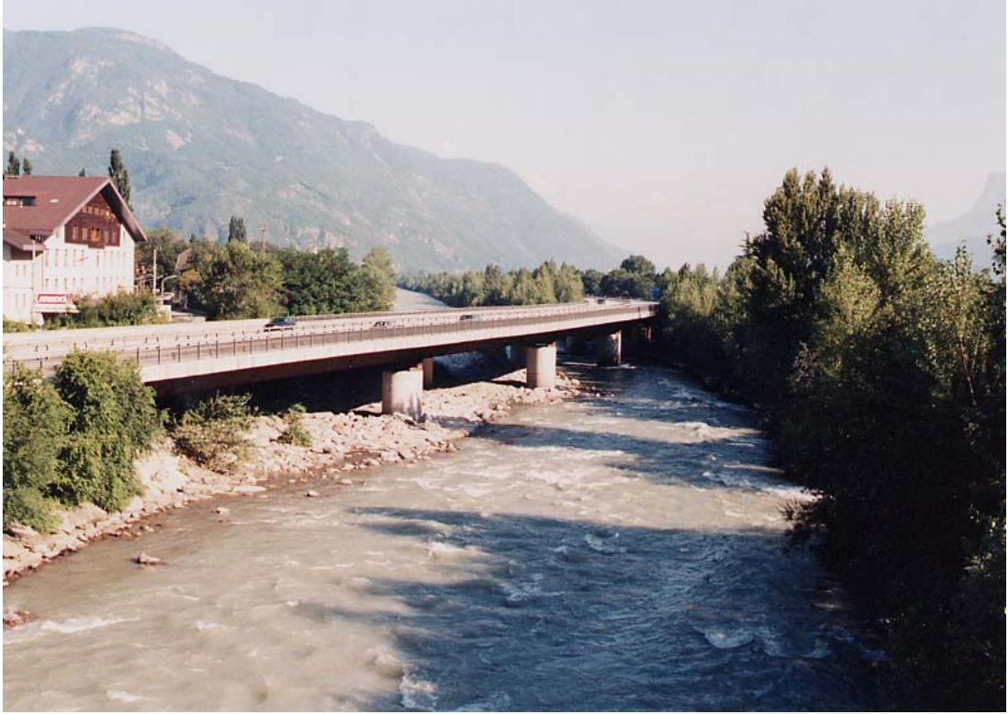
Km 73.3 – Veduta dal ponte della S.S. n.236, guardando verso valle.
