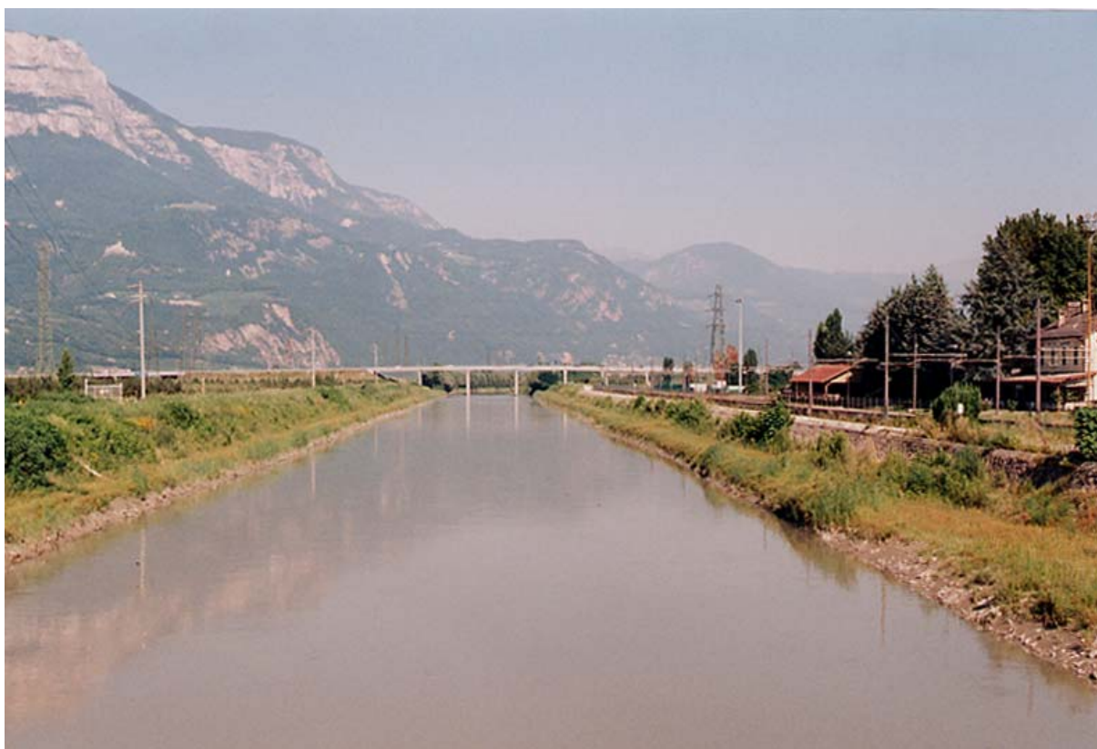
Ponte d'Adige. Km 97.3 – Vista verso la sorgente.
