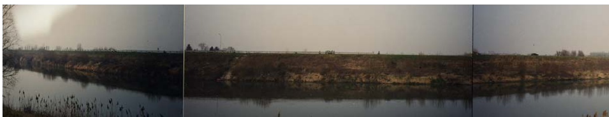
Km 344.8 – Argine sinistro su cui scorre la S. P. n.1.
