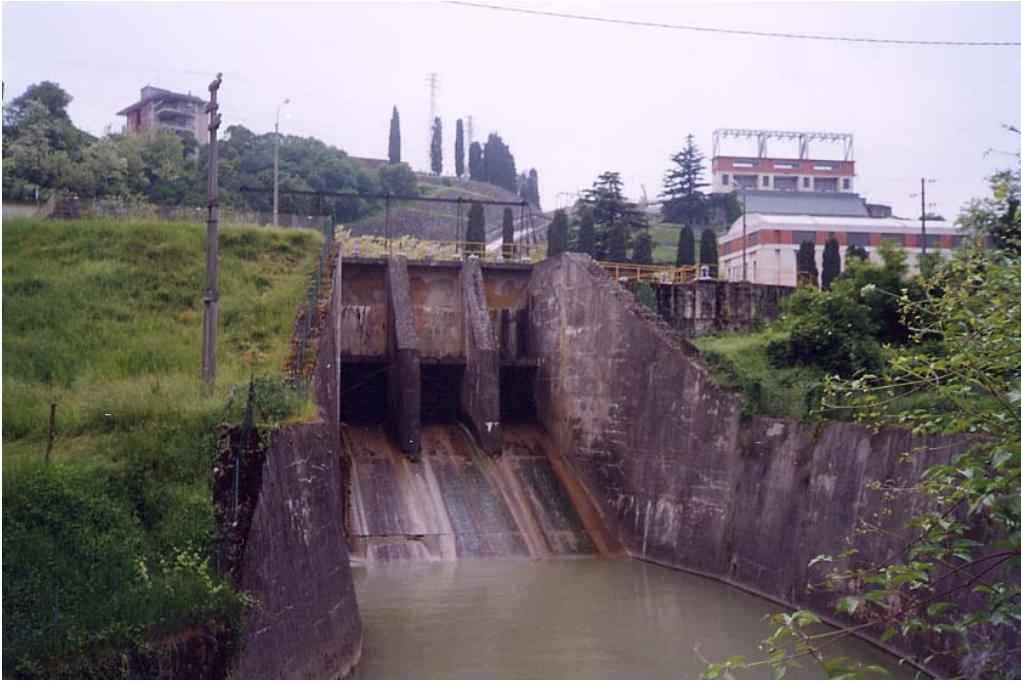
Km 237.5 – Centrale elettrica di Bussolengo.
