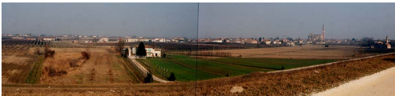
Km 327 – Panoramica dall'argine sinistro verso l'interno, sulla destra Castelbaldo.
