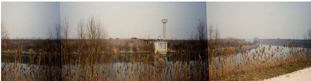
Presa dell'acquedotto di Piacenza d'Adige. Km 337.5.
