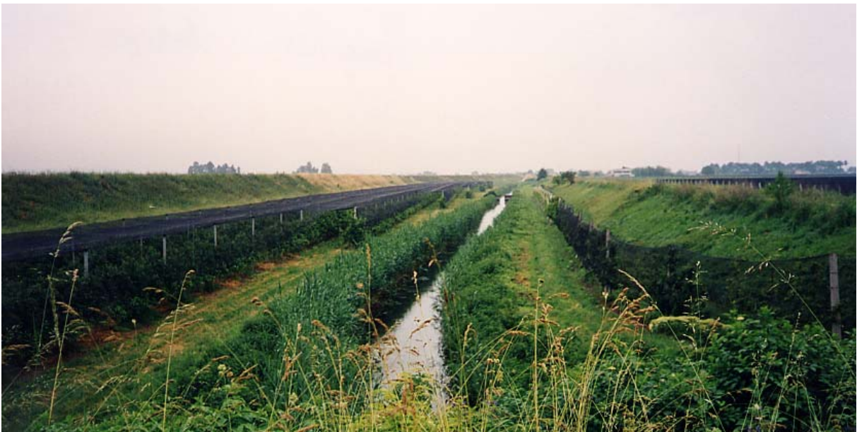
Km 276.2 – Fosso tra il canale S.A.V.A. (sulla sinistra) e l'argine dell'Adige (sulla destra).
