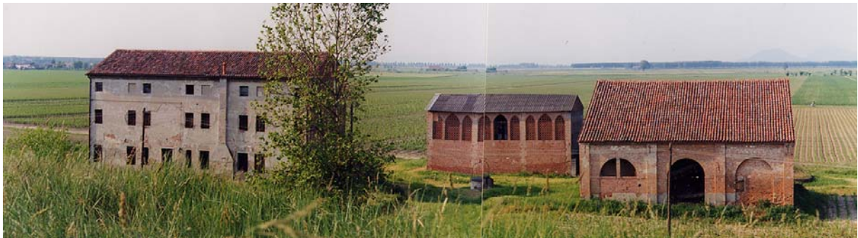
Edifici storici. Km 339.1.
