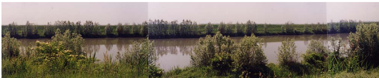
Km 223.5 – Vista dell'argine destro dell'Adige.
