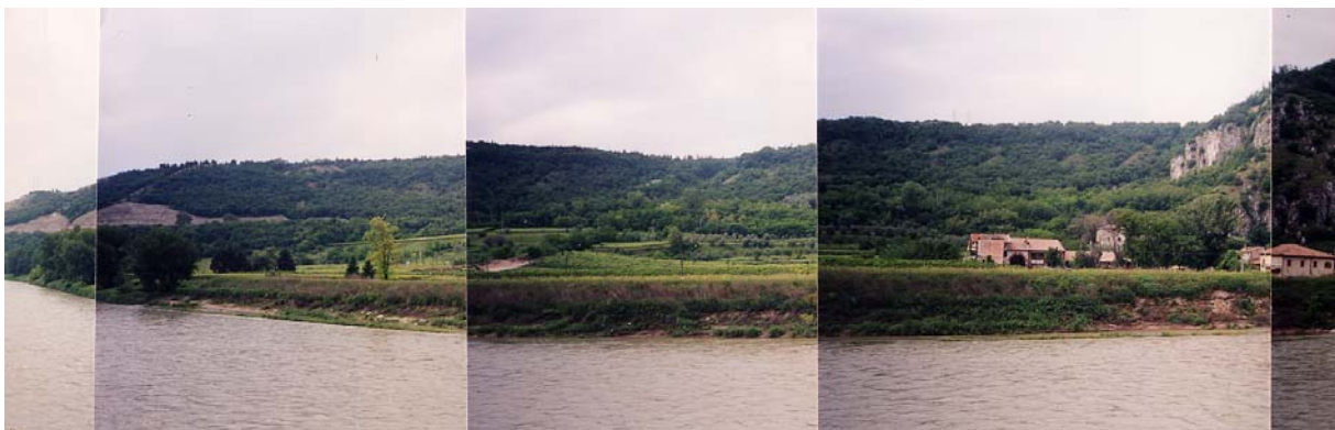
Km 227.6 – Panoramica della riva destra. Sulla sinistra si vede il muro di contenimento del canale Biffis.
