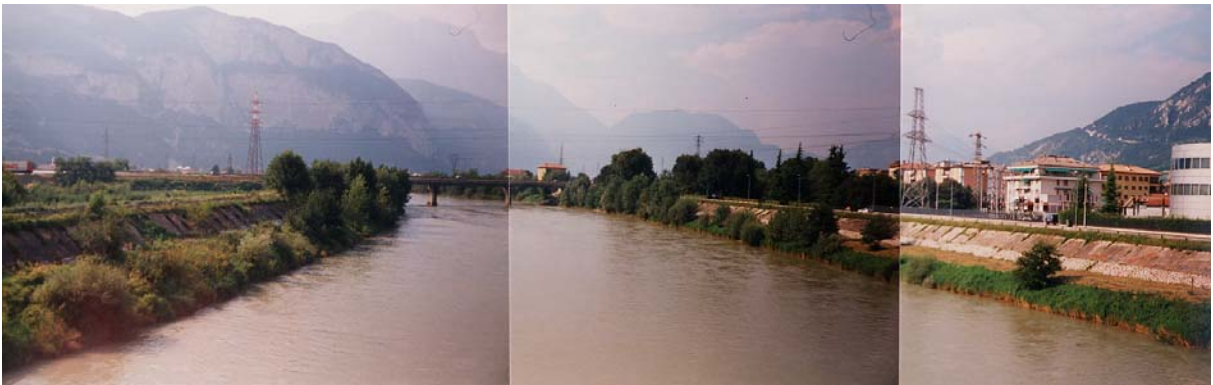
Ponte S. Giorgio. Km 152.2 – Panoramica verso nord.
