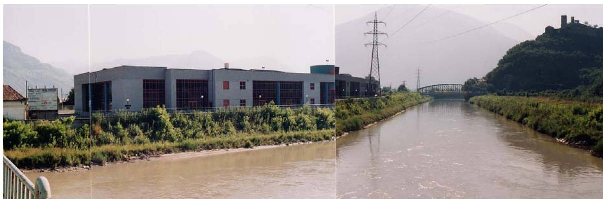
Ponte d'Adige. Km 97.3 – Vista verso valle.
