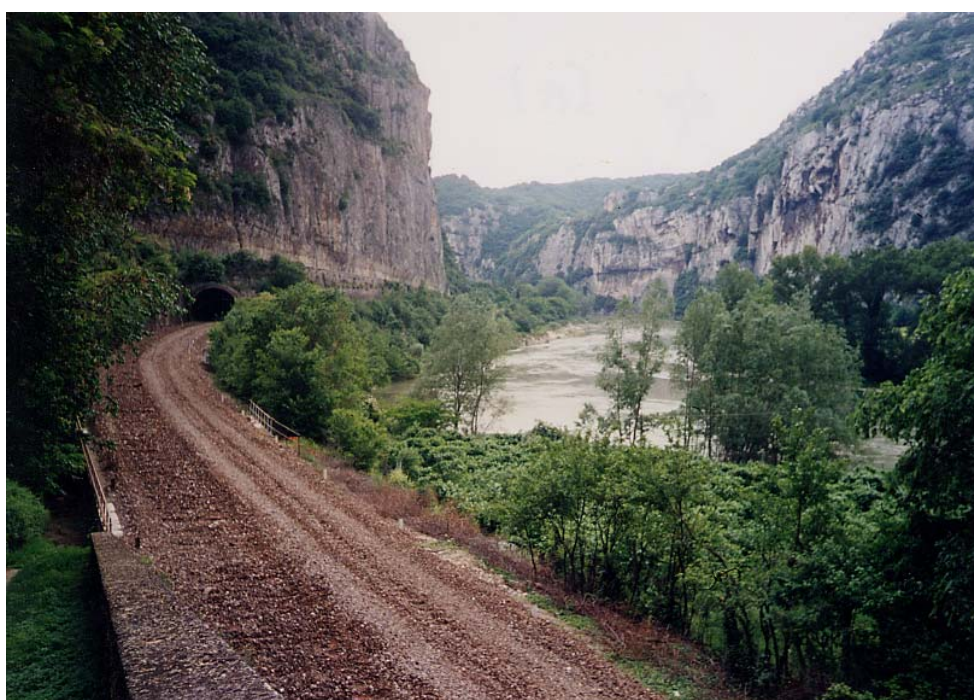
Km 224.8 – Panoramica dal sentiero in sinistra Adige, vecchio tracciato ferroviario.
