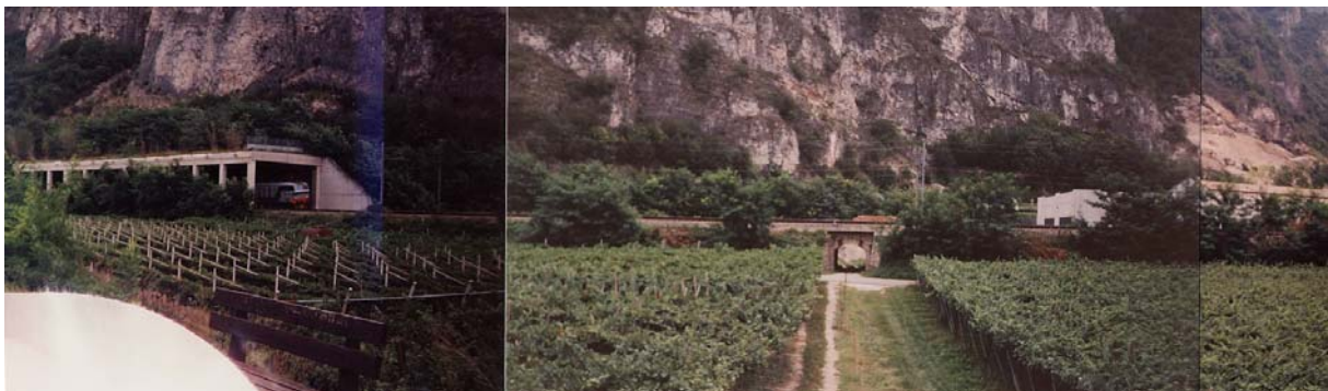
Km 166.5 – Riva sinistra, vista verso l'interno.
