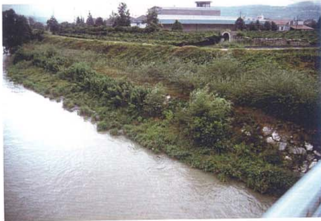
Visione generale dell'ADR. Si osservi in particolare la riva artificializzata con scogliere non cementate e parzialmente rinaturalizzata.
