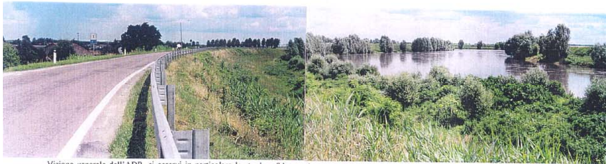
Visione generale dell'ADR, si osservi in particolare la strada asfaltata sul secondo argine e il canneto sulla scarpata.
