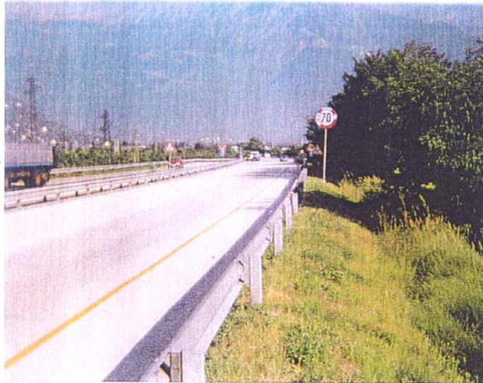
Tratto della superstrada Merano - Bolzano costruita sull'argine destro dell'Adige;
