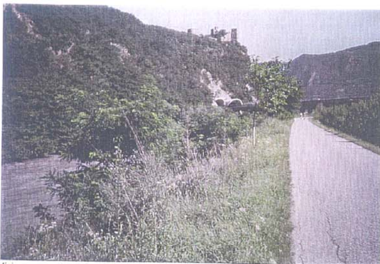
Visione generale dell'ADR. Si noti l'alveo, la ripa costituita da scogliere non cementate, la vegetazione riparia (limitata ad alcuni esemplari di Robinia pseudoacacia ), la pista ciclabile sull'argine.
