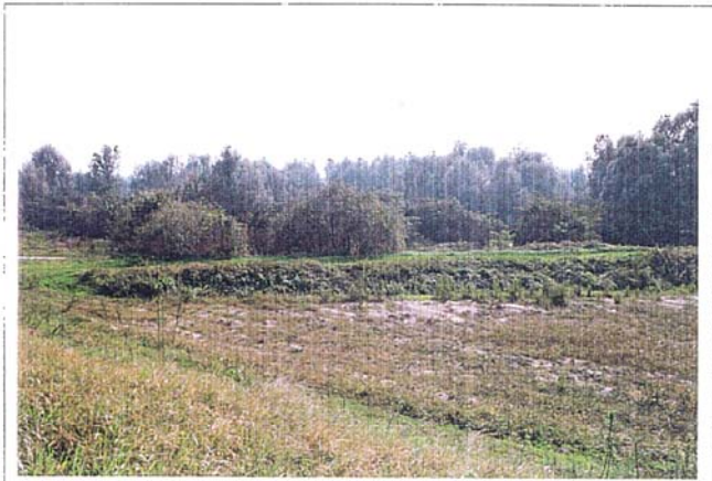
↓ Foto n° 4 ADR vista dall'argine esterno
