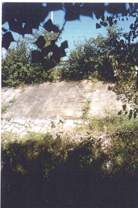
Particolare dei rinforzi in cemento sull'argine semplice e transitabile.
