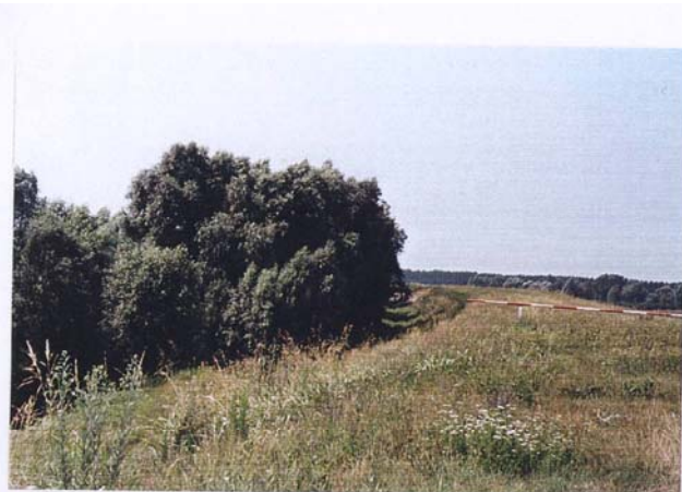
Visione generale dell'ADR, si osservi la carrareccia arginale non transitabile a causa sbarramenti.
