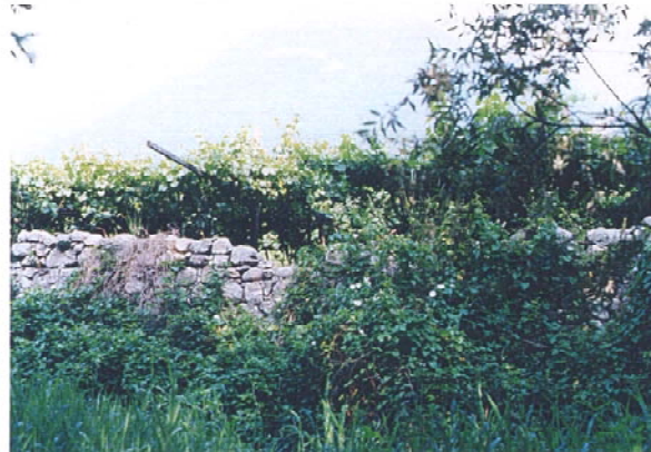
Particolare del muretto a secco che divide l'ADR dal retrostante vigneto.
