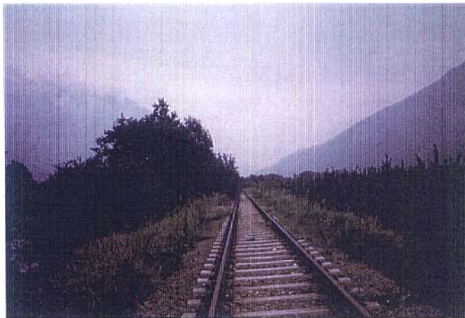
Visione generale dell'ADR. Si osservino la ripa naturale di terreno trattenuto da alberi ed arbusti, l'argine percorso dalla strada ferrata ed il frutteto.
