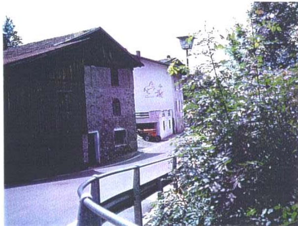
Visione dell'area urbana all'interno dell'ADR.
