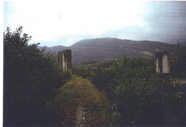
Particolare della carrareccia in ADR e delle costruzioni isolate precarie rappresentate dai resti di un ponte.
