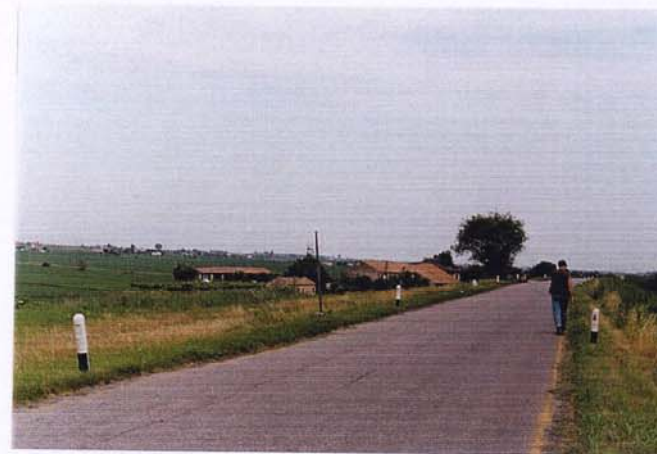
Particolare della strada arginale, asfaltata.
