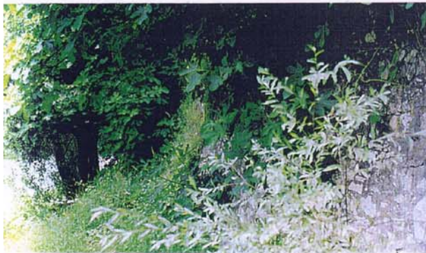
Particolare della riva con il muro di terrazzamento che arriva a pochi metri dal fiume.
