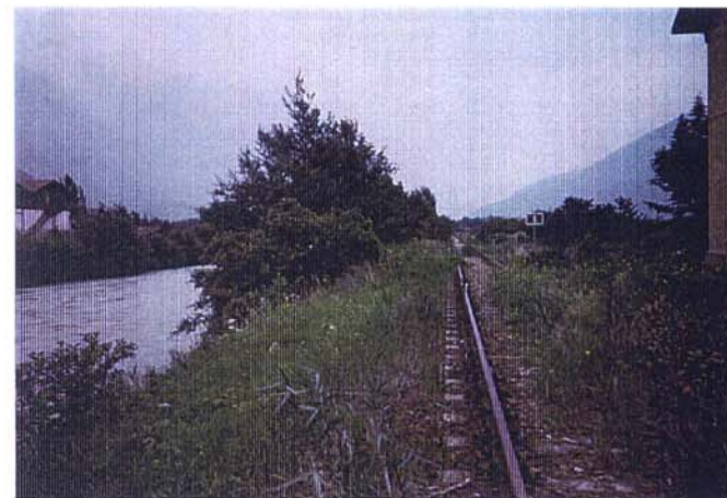
Particolare dell'alveo e della vicina linea ferroviaria.
