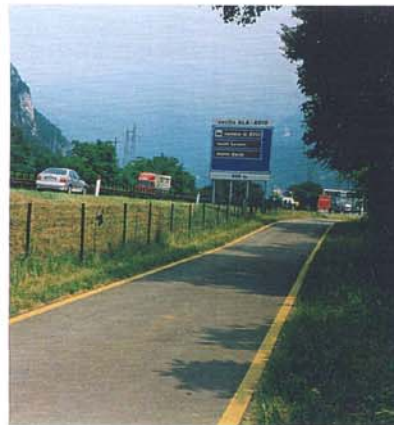
Strada asfaltata in ADR. Il limite dell'area è dato dall'autostrada.
