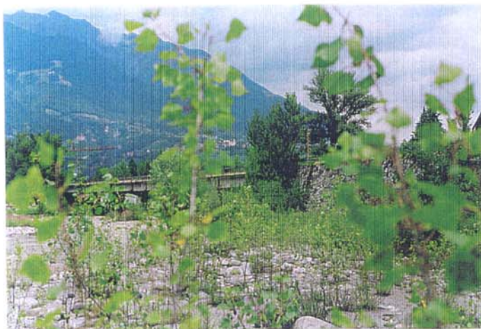
Particolare del muraglione e della superstrada nelle vicinanze dell'ADR.
