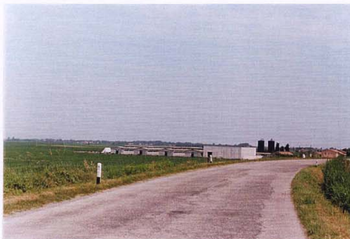
Pesaggio circostante, prevalentemente agricolo, sulla sponda orografica sinistra e particolare della strada arginale, asfaltata.
