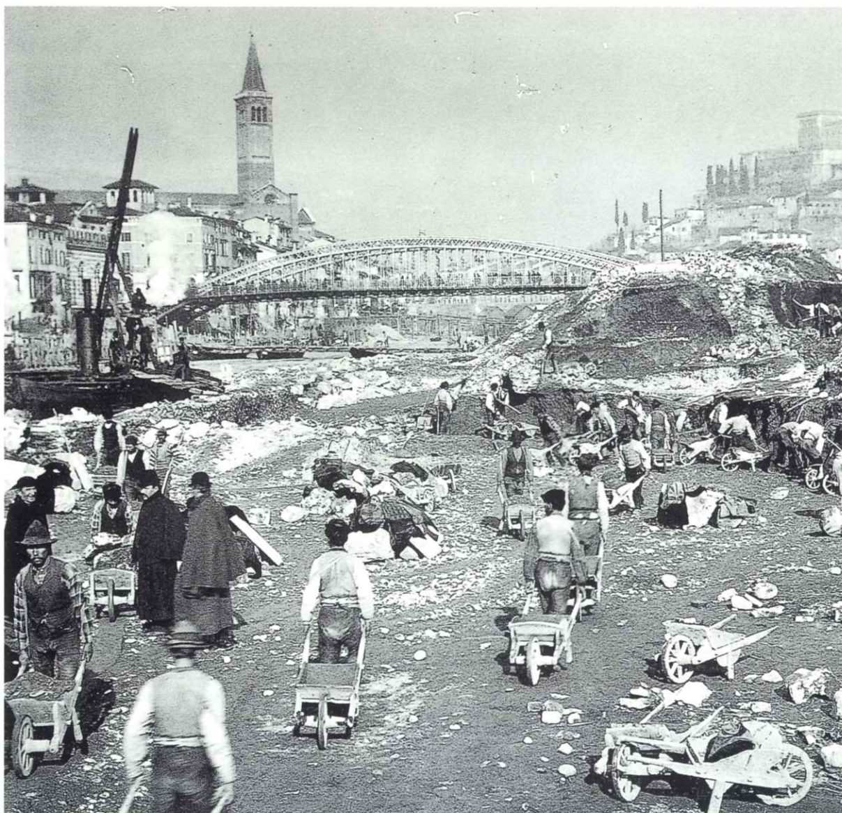
L'Adige a Verona nel 1891. Costruzione degli argini nell'ambito del tessuto urbano
