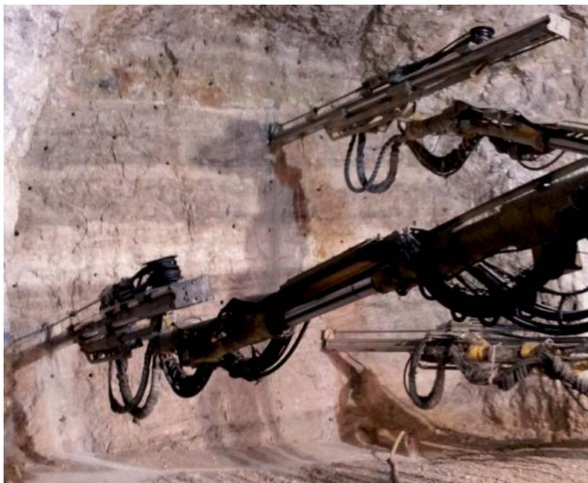
Fig. 6 - Fronte di avanzamento in galleria. Preparazione dei fori per l'esplosivo. Le varie tonalità degli strati di dolomia corrispondono a differenti litologie.
