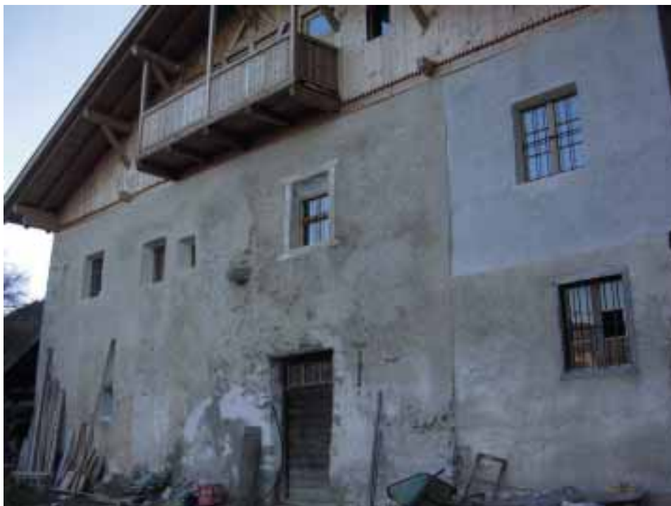
Fig. 1 - Dettaglio della facciata sud dell'edificio.
