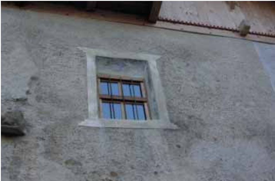
Fig. 4 - Dettaglio della finestra con cornice di malta e vetri e scuri a scivolo.
