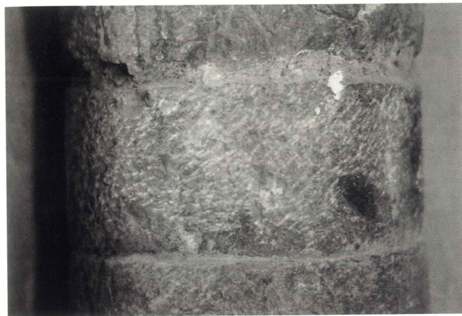
Fig. 2 - Particolare della fig. 1 con evidenziata la diversità dei materiali e delle martellinature dei tre pezzi costituenti il 'monolito' e le relative legature a malta.
